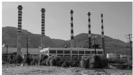
DELTA DUCT DERMITZAKIS Υποσταθμός ΔΕΗ, Δαμάστα Ηρακλείου
