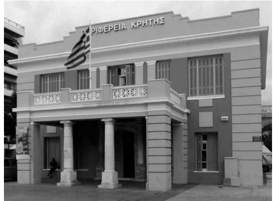
DELTA ELECTRICAL DERMITZAKIS Κτίριο Περιφέρειας Κρήτης
