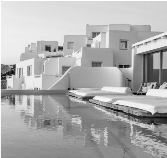
DELTA ELECTRICAL DERMITZAKIS Cavo Tagoo, Mykonos
