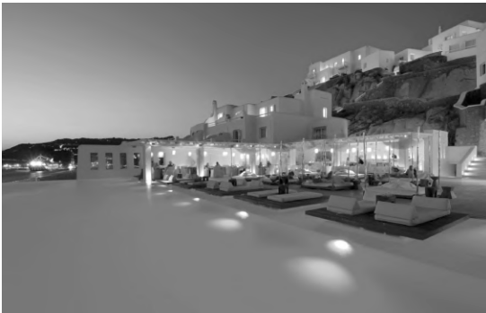
DELTA DUCT DERMITZAKIS Cavo Tagoo Santorini
